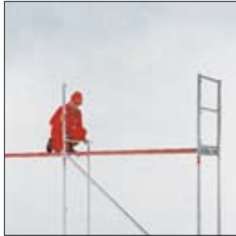
Geländerpfostenstützen aufstecken
