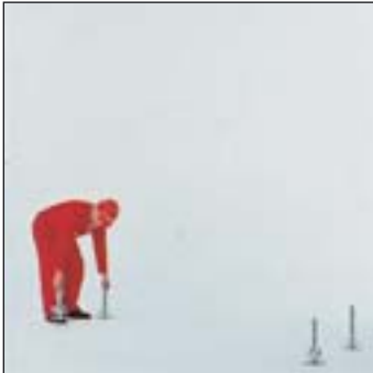
Gewindefußplatten aufstellen
