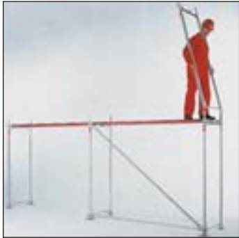
Vertikalrahmen der nächsten Lage(n) aufstecken
