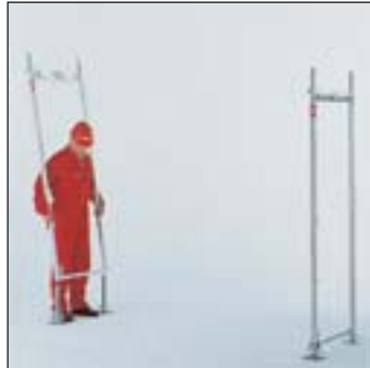
Vertikalrahmen aufstecken
